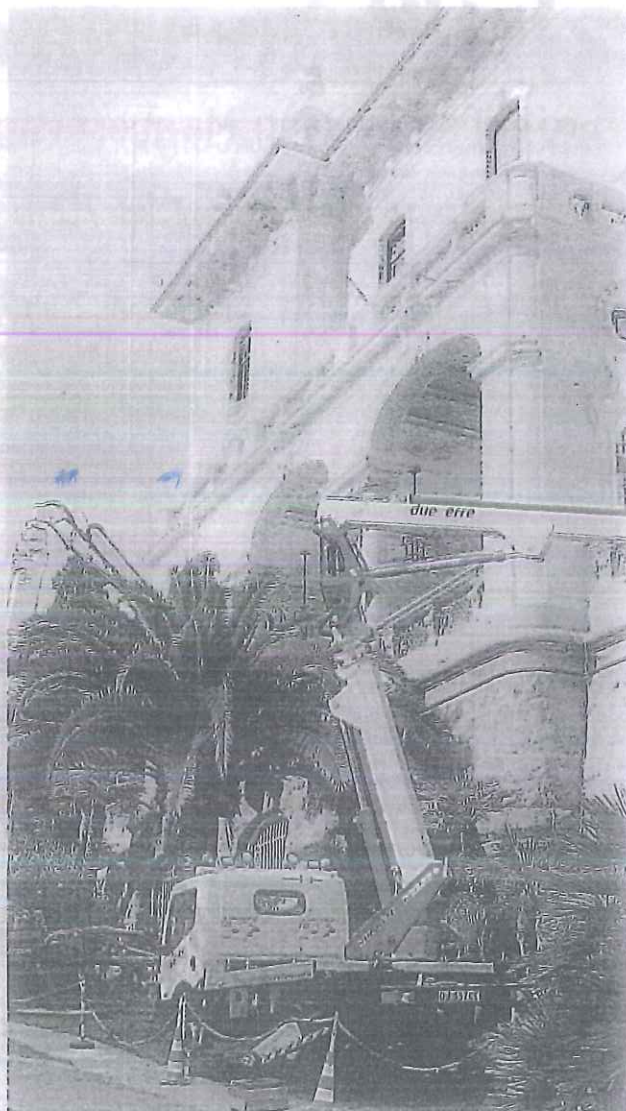
I lavori a Villa Regina Margherita
